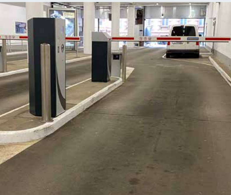
Bescherming van installaties binnen, bijvoorbeeld automatische betaalautomaten, slagbomen
